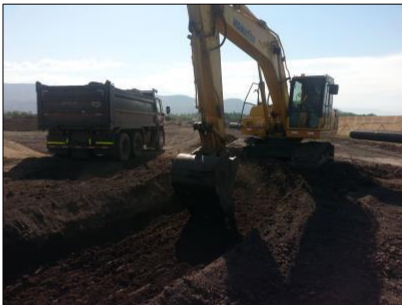
Figura 13. Proceso de excavación de zanja para tubería T1.
