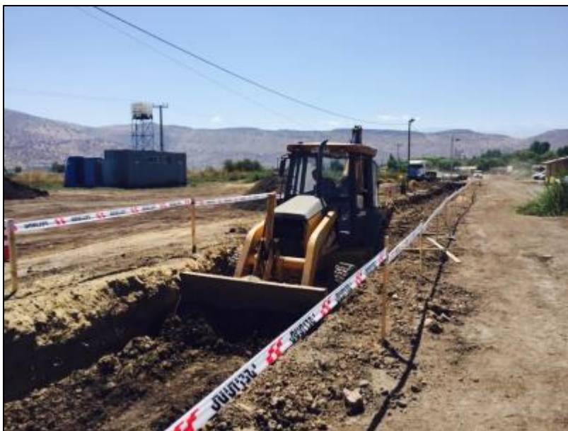
Figura 14. Retroexcavadora realizando escarpe en la excavación de la tubería.
