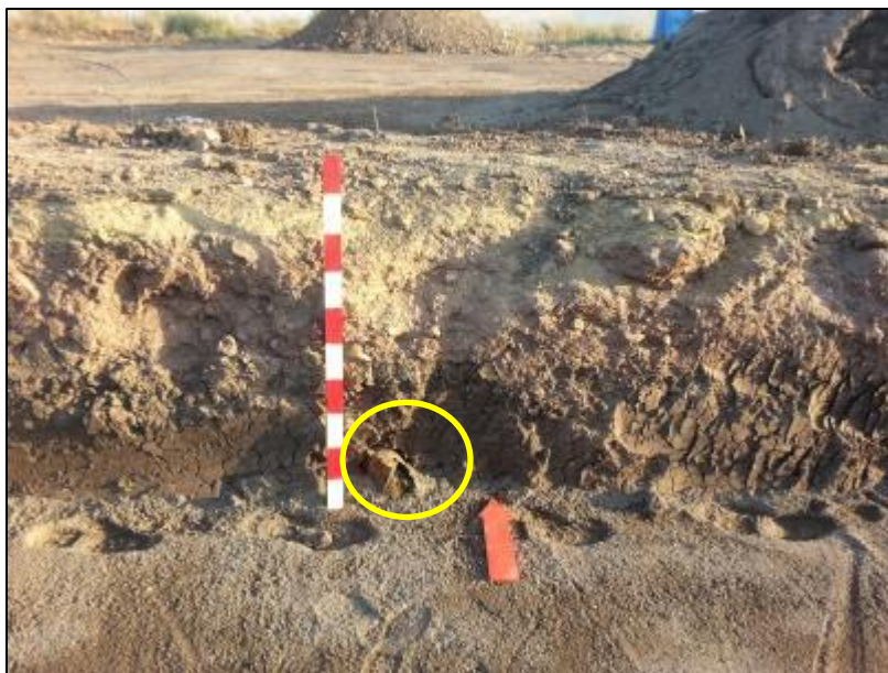
Figura 16. Vista perfil Norte, se encontró a los 70 cm de profundidad, una pequeña tubería galvanizada de 10 cm de diámetro que atravesaba la zanja de Norte a Sur.
